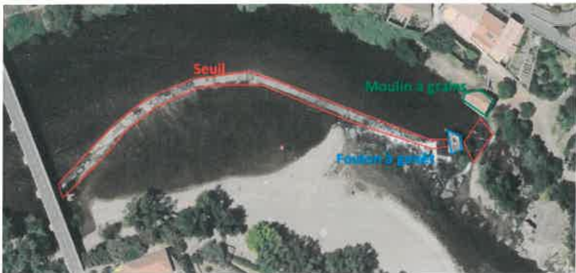
Figure 1 : Vue aérienne du seuil de Roquebrun
