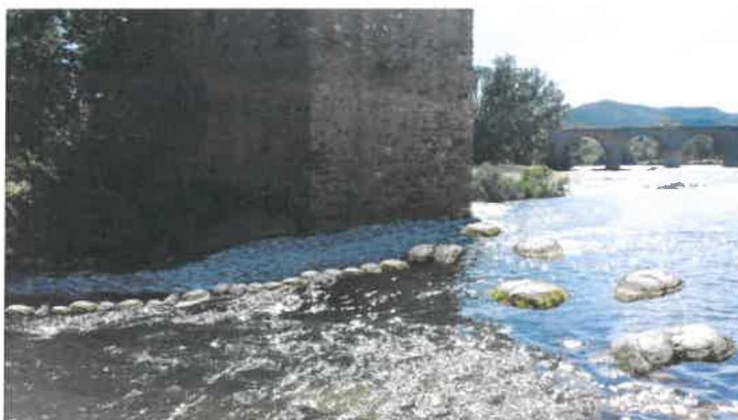
Figure 8 : Illustration par photomontage de la mise en place des pas japonais – Scénario 1
