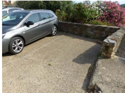
Principe de marquage des stationnements réalisé place de l'église par une simple bande structurante pavée
