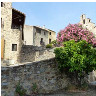
Soutènement maçoné dans le village
